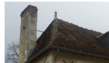
Arêtier en tuiles creuse avec scellement au mortier de chaux traditionnel
