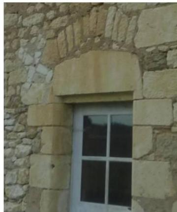
Baie avec linteau monolithe et arc de décharge
