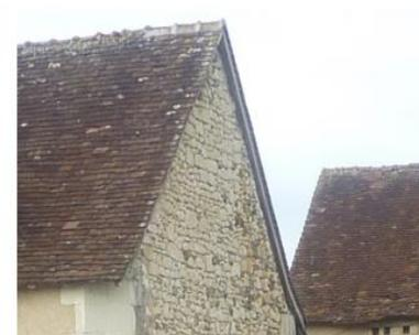
Chevron de rive apparent : la pose d'un chevron au droit de chaque parement permet une meilleure ventilation des tuiles
