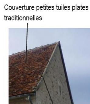
Rive réalisée au mortier de chaux traditionnel avec dérivure
