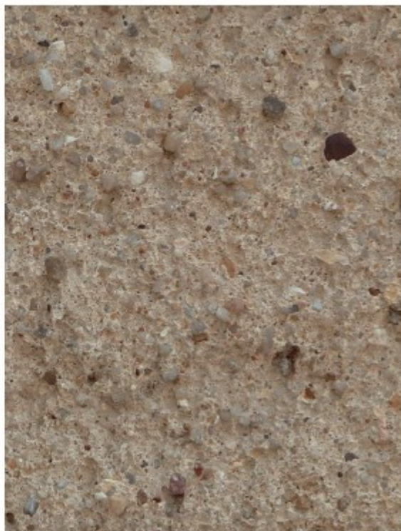
Grand-Pressigny - annexe - finition grattée - érodé
