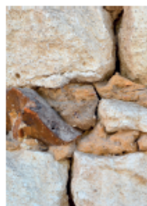
Maçonnerie en moellons de calcaire à falun et de silex, hourdée à la terre (Etableau)
