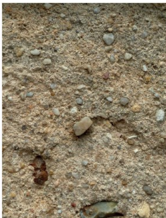
Courvaux - annexe rurale - finition talochée - érodé
