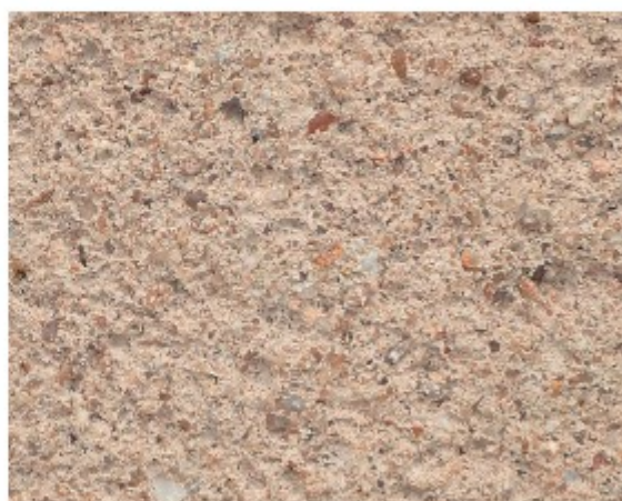
Grand-Pressigny - mur de clôture - finition grattée
