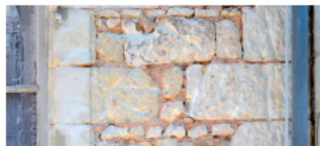
Maçonnerie de moellons calcaires soigneusement assisés (Maison de bourg du Grand-Pressigny)
