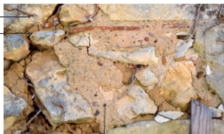
Enduit de sable jaune et graviers de grès rouge, schiste, silex roux, chocolat et gris
