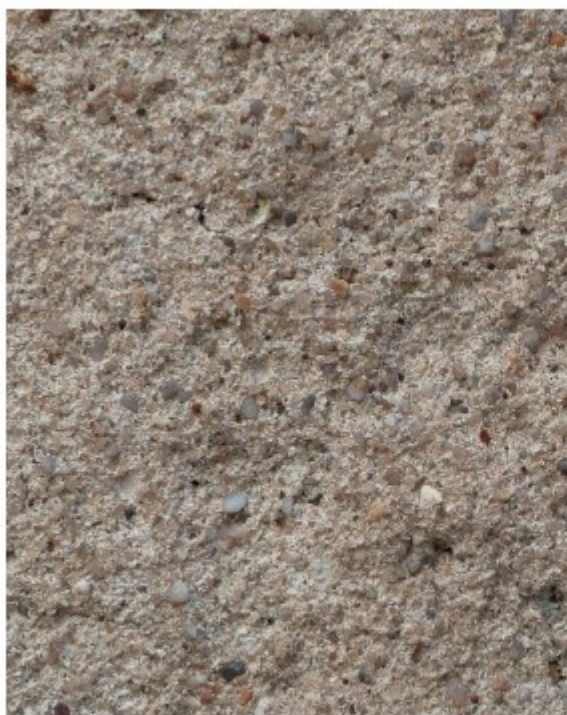
Grand-Pressigny - bâtiment institutionnel - finition talochée
