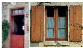
Menuiseries de logis de ferme
