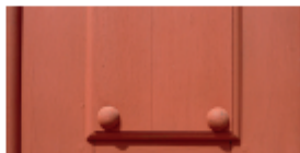
Peinture à l'ocre rouge foncé (ocre rouge 50% et hématite 50%) Opération «Couleurs locales» menée par Terres & Couleurs à Richelieu (37)
