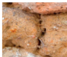
Mortier de terre - détail : terre, gravillons et paille
