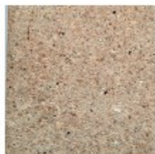
Enduit de finition (Grand-Pressigny)
