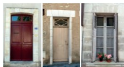
Menuiseries de maison de maître et de bourg
