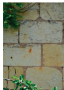
Maçonnerie appareillée de tuffeau blanc et jaune
