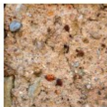
Enduit de finition (La Malgache)
