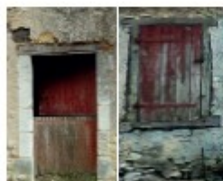
Menuiseries de logis de manouvrier
