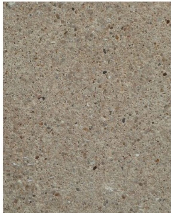
Grand-Pressigny - maison de bourg - finition lissée et feutrée
