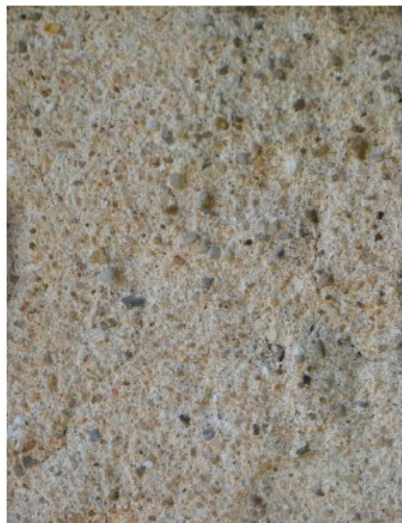
Le Roulet - annexe rurale - finition grattée - érodé
