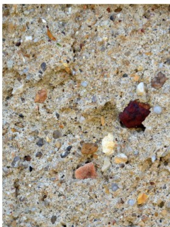
Baudichonnerie - annexe rurale - finition talochée - érodé
