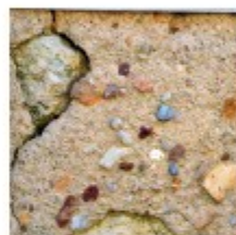
Enduit de finition (La Bourdinerie)
