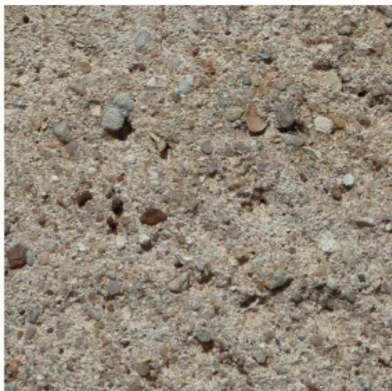
Grand-Pressigny - maison de bourg - finition talochée
