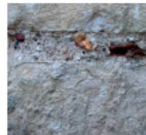
Jointoiement de pierres appareillées (église)
