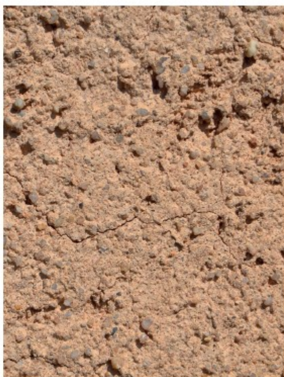
La Malgache - annexe rurale - finition talochée - érodé
