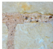
Jointoiement de pierres appareillées (Le Roulet)
